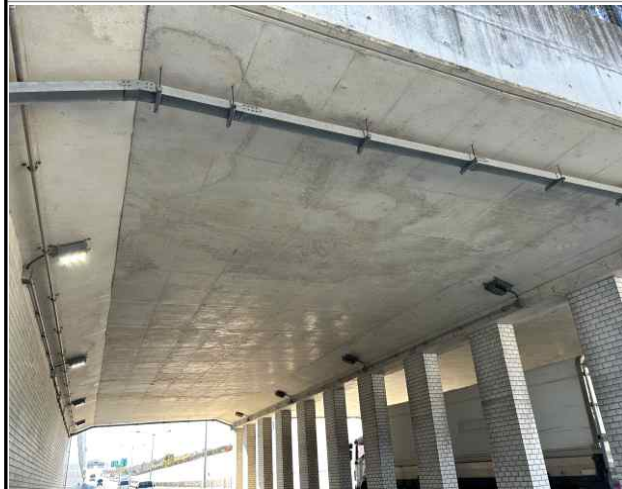
BOX 슬래브하면 전경
