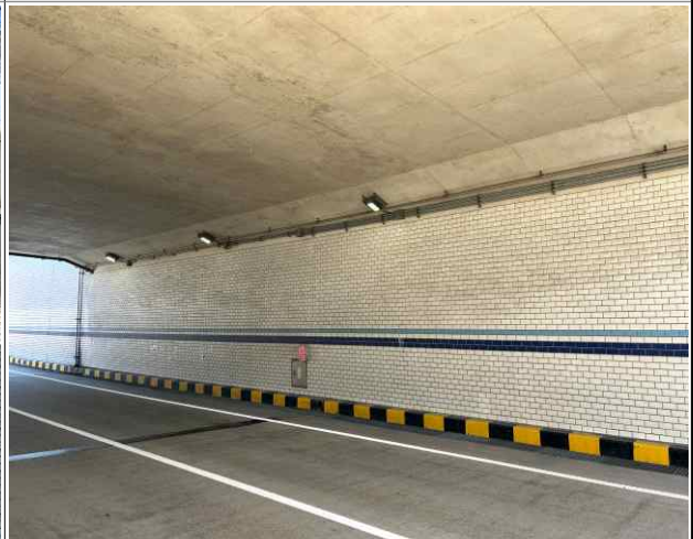
BOX 벽체 전경
