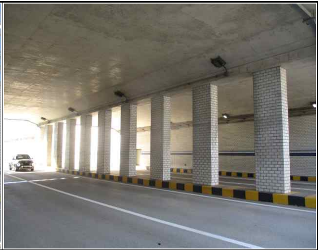
BOX 내부 전경
